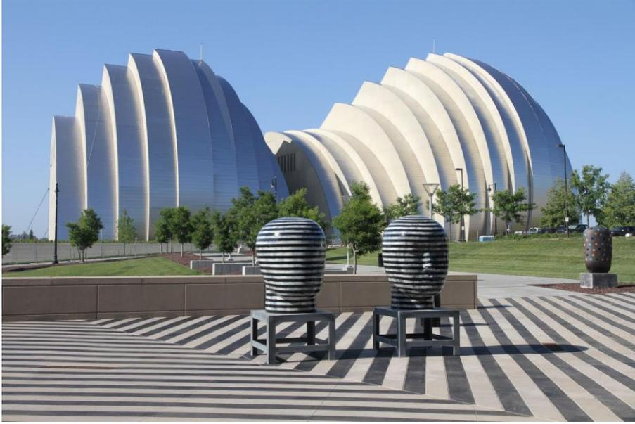
هذه القبة وهي موضحة بالشكل (4 – 29) هي بالحقيقة نفس القبة السريرية التي تستند على حرفيها المستقيمين والتي جرت دراستها سابقاً يكون التموج بالمقطع هو بالاتجاه العرضي فقط. يكون التموج بهذه الحالة هو أيضاً لزيادة مقاومة المقطع للتحنيب الموضعي. كذلك لا تستخدم هذه القشرية إلا عندما تكون السماكة رقيقة جداً، ونخشى من التحنيب الموضعي وذلك لتجنب التكاليف الزائدة للقالب المموج.
