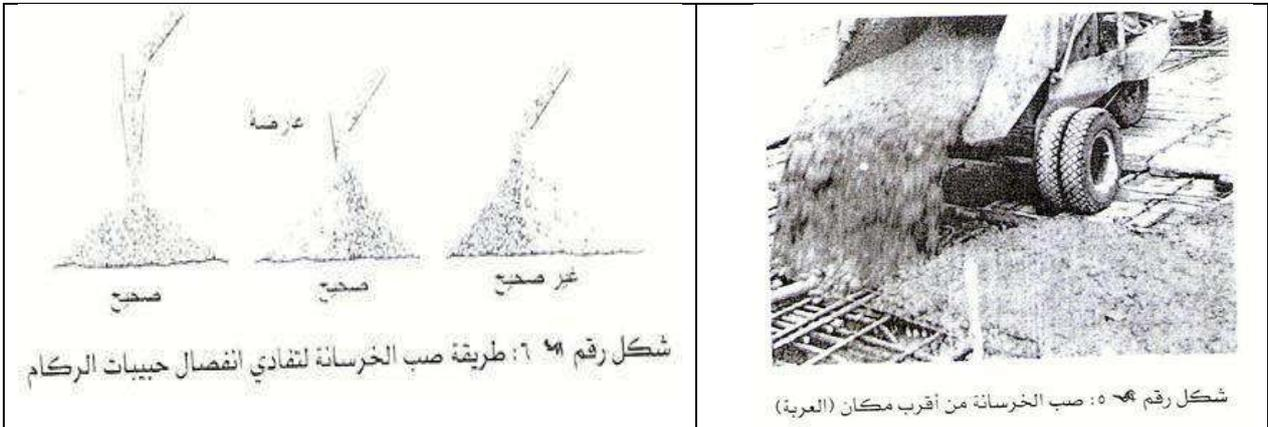
عند صب البلاطات الأفقية أو المائلة، يجب تفرغ الخرسانة في وجه التي سبق وضعها من قبل (شكل رقم ٧ و ٨).
